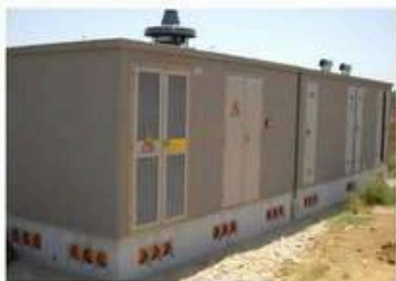
Le cabine di trasformazione MT/bt sono necessarie al cliente finale dall'alto fabbisogno energetico, dove l'ente distributore ricorre alla fornitura di energia in Media Tensione e l'utente deve provvedere in autonomia alla sua trasformazione in Bassa Tensione.
